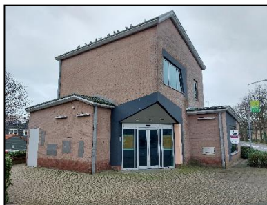
Figuur 3. De noordelijk georiënteerde gevel van de aanwezige bebouwing op de onderzoekslocatie.
