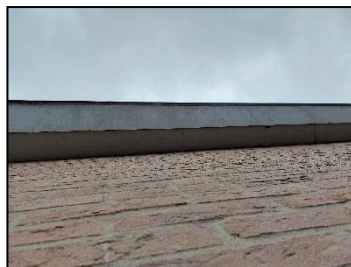
Figuur 10. Ruimte achter de daklijst van de aanwezige bebouwing.
