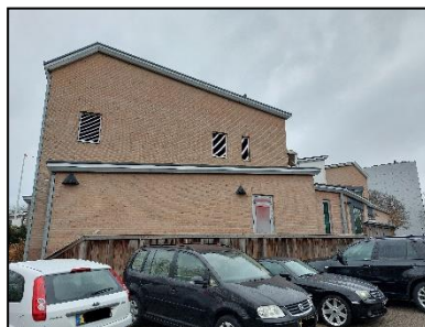
Figuur 4. De oostelijk georiënteerde gevel van de aanwezige bebouwing op de onderzoekslocatie.
