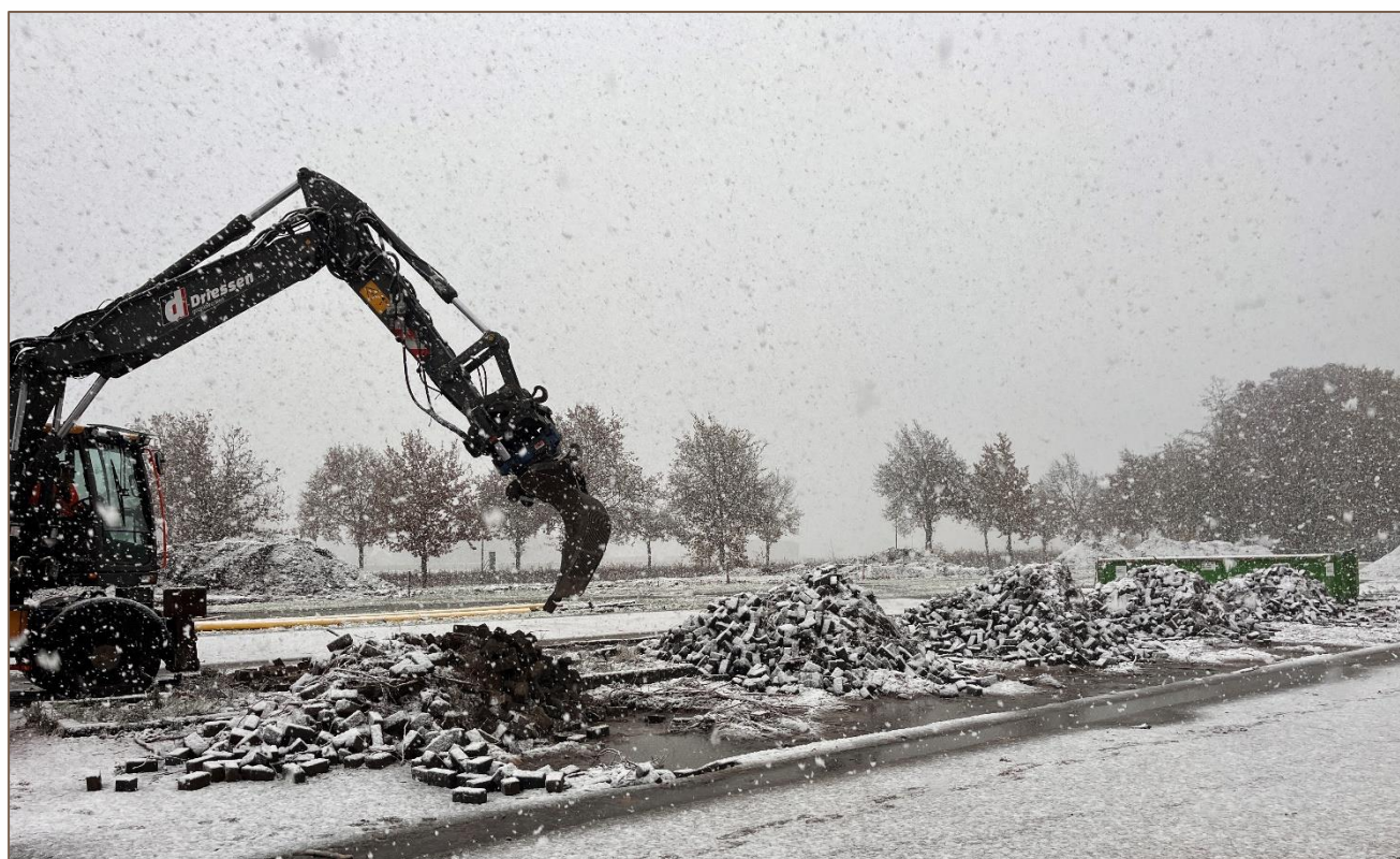
Figuur 2. Uitgraven van werkput 6 onder winterse omstandigheden.
