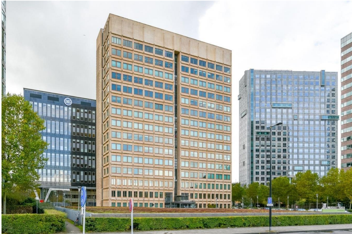
Afbeelding: huidige situatie projectlocatie
