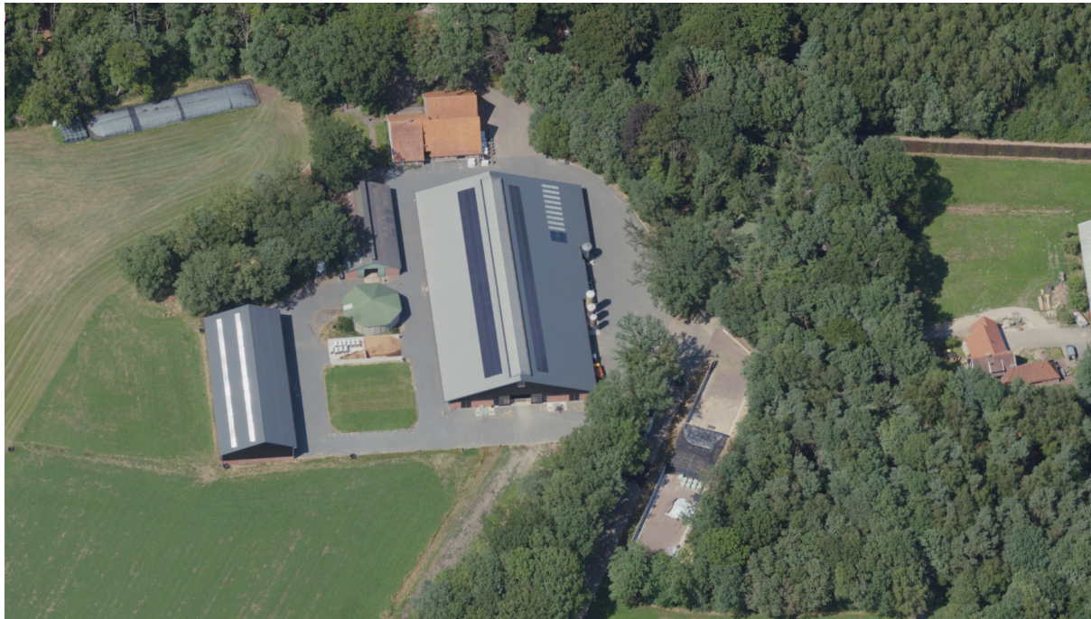
Afbeelding 2.1: aanzicht huidig erf beekzijdeweg 44, diverse buitenopslag zichtbaar (bron: Streetsmart)
