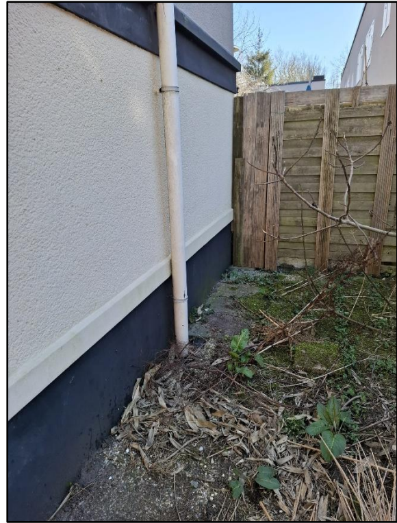
Door deze schutting te verwijderen is er toegang tot de tuin.
