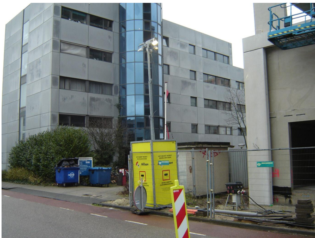
Afbeelding 3: Projectgebied vanaf de Paasheuvelweg vanuit zuidwestelijk oogpunt (bron: Adromi)
