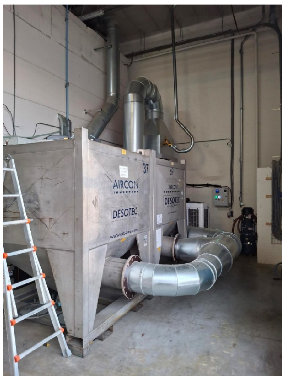
Figuur 1 Nabehandeling proceslucht in twee parallel geschakelde koolfilters
