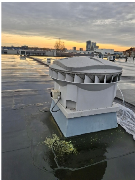
Figuur 2 Afvoer koelmachine
