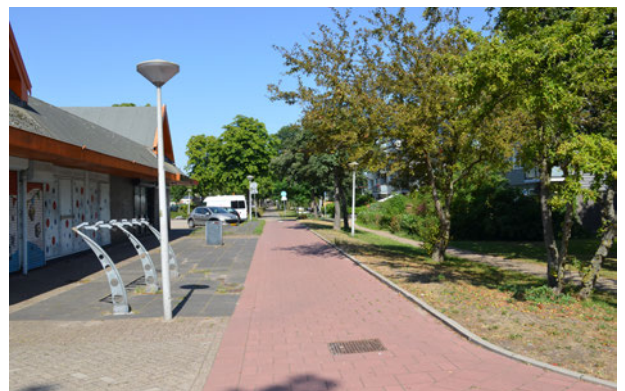
Huidige situatie Fokkemast
