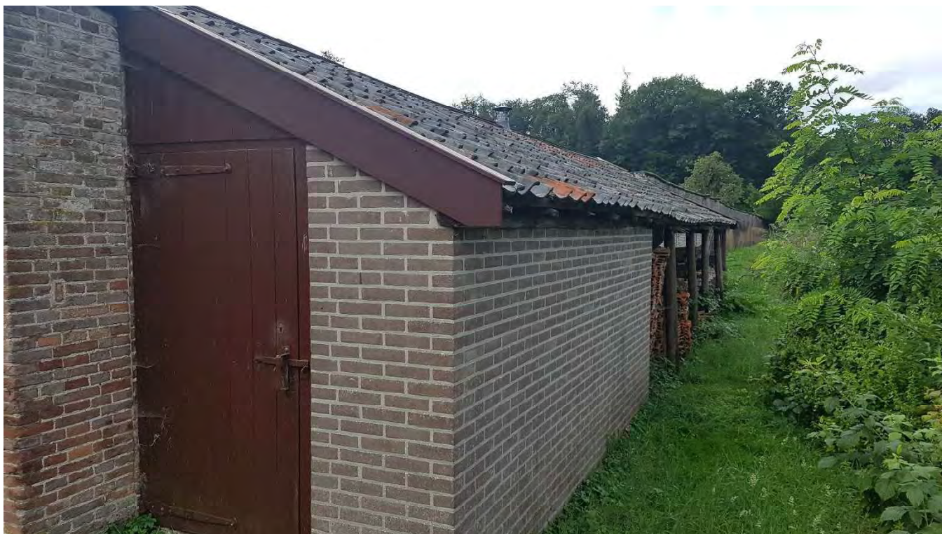
6 Tuinmuur met een klein schuurtje zodat de muur meer stabiliteit en gelijk een functie heeft.
