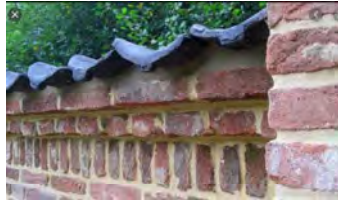
Rollaag en afdekking met oud-Hollandse pannen.
