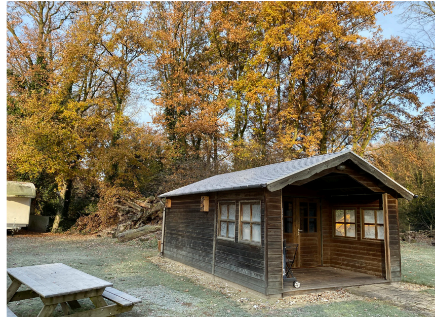
Figuur 17: Bestaand bijgebouw t.p.v. nieuw te bouwen slaapgelegenheden
