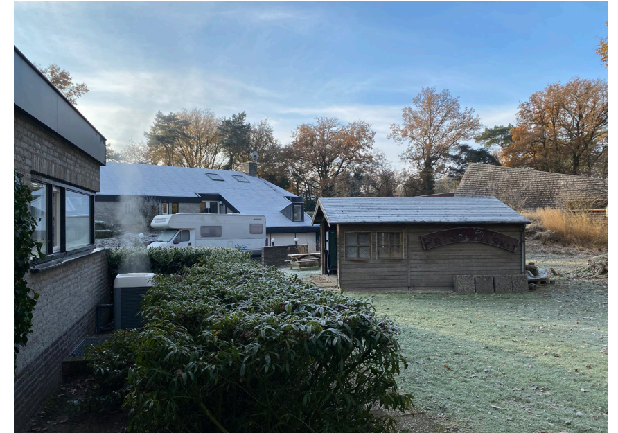
Figuur 18: Links zwembad, achter woonhuis en rechts bestaand bijgebouw
