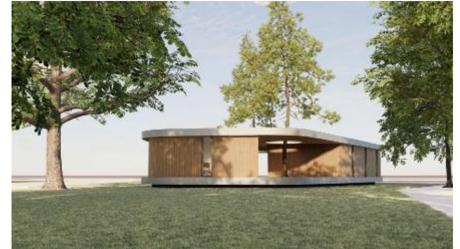
Figuur 6: Gebouw gezien vanuit het zuidoosten
