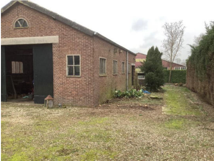
Aanzicht van de loods
