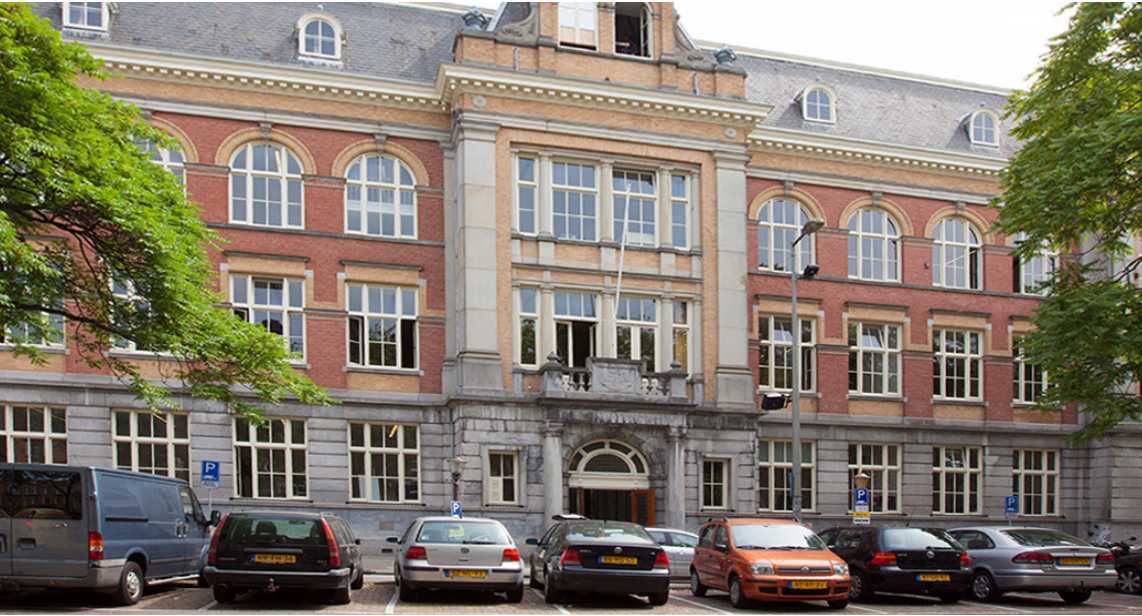
gevel HES gebouw
