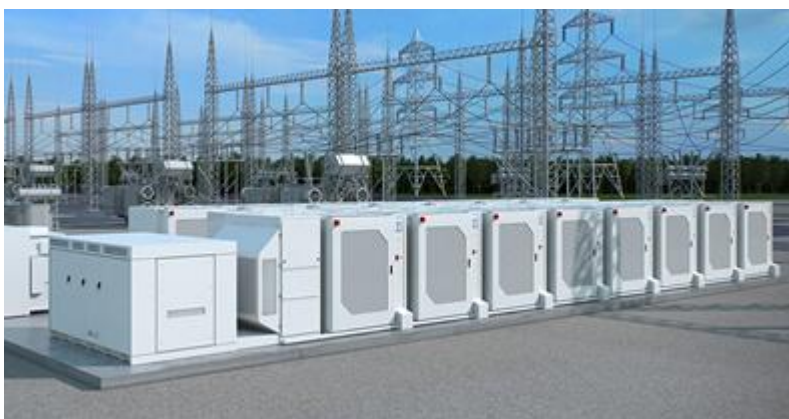
Voorbeeld Niet-betreedbare EOS in de openlucht
