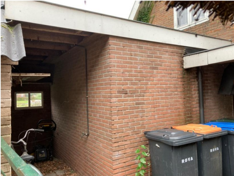
Oorspronkelijke aanbouw pens. woning nr. 310
