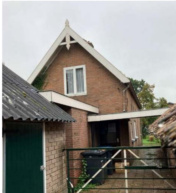
Oorspronkelijke aanbouw pens. woning nr. 310
