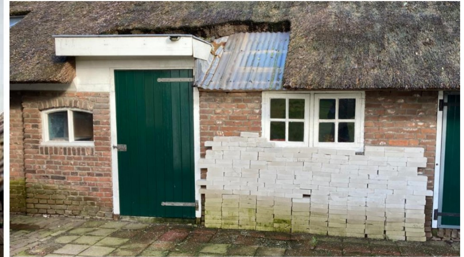
Plat dak aansluiting in riet, zoals het nu is (overig plat dak verwijderd)
