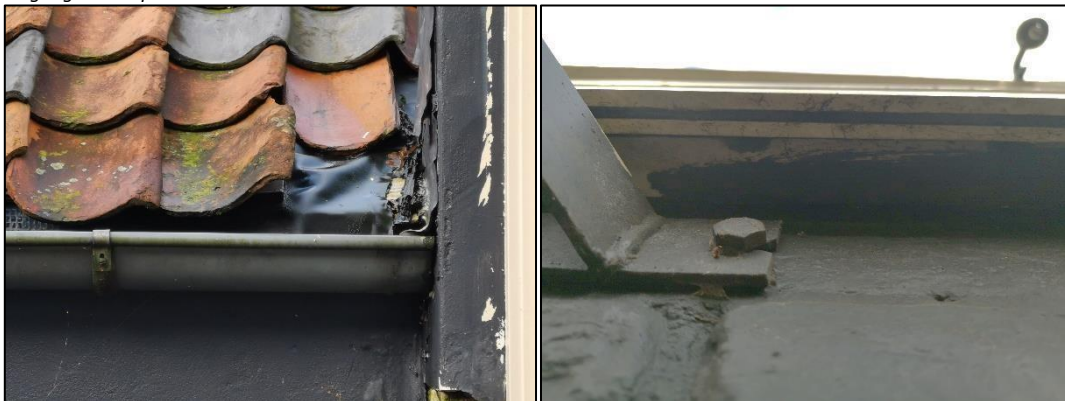
Figuur 2.7 (links): Zicht op het dak van een van de andere bijgebouwen, welke voorzien is van folie en geen toegang tot de bebouwing biedt; Figuur 2.8 (rechts): Zicht op de gevelbetimmering, welke strak aan de gevels aansluit..
