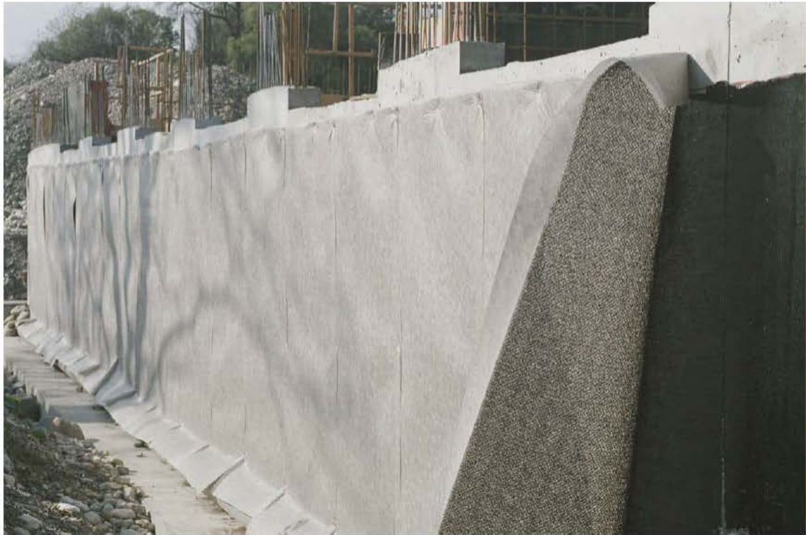
Figuur 1: Illustratie Enkadrain drainagemat in verticale toepassing
