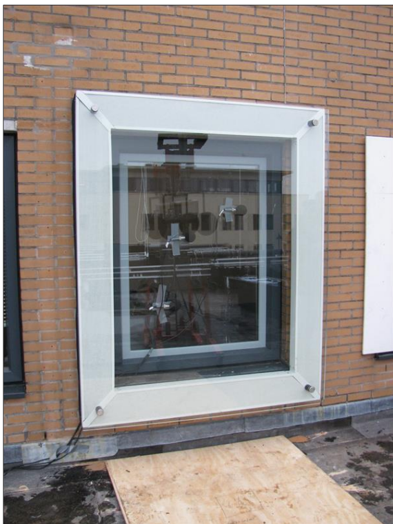
Foto II.3 Aanzicht glazen gevelgeluidscherm
