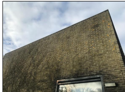
Foto 12. Overhangend metalen dakrand bij bedrijvenpand
