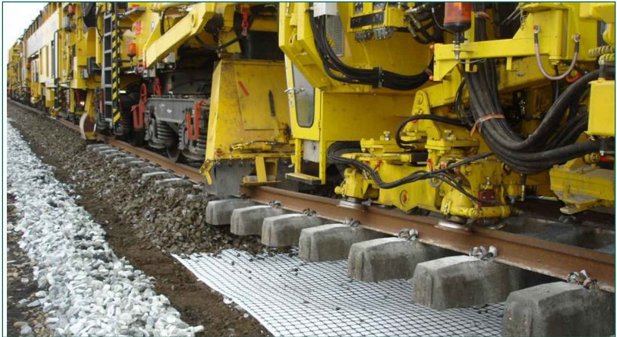
Figuur 21: Voorbeeld aanbrengen nieuw ballast in combinatie met geotextiel (Bron: De Stentor april 2017)).
