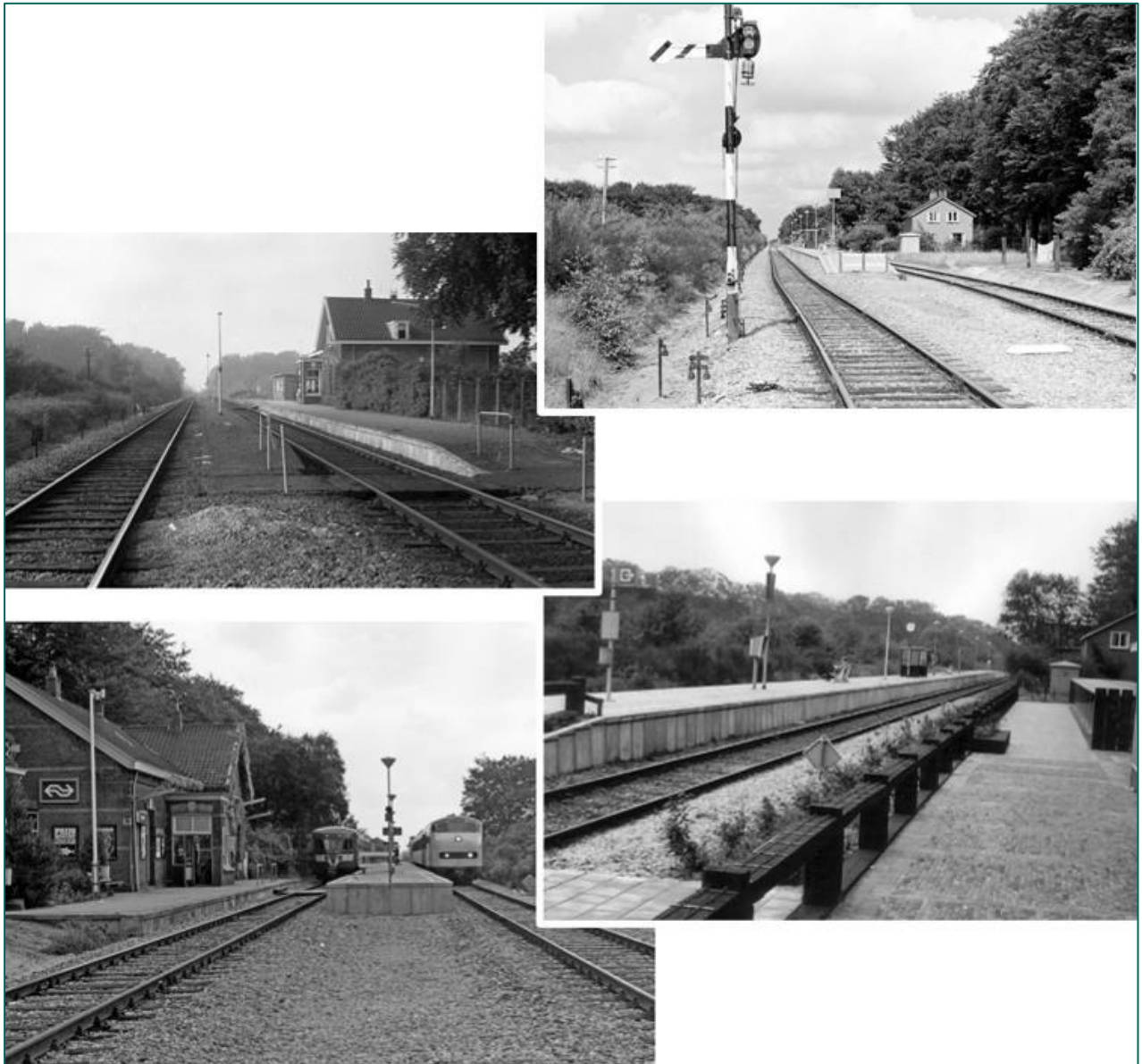
Figuur 25: Het emplacement in oostelijke richting met de kruisende treinen richting Raalte en Zwolle medio jaren 70 (Bronnen: www.stationsweb.nl en https://www.klassiekebeveiliging.com/seinhuizenHno.htm ).
