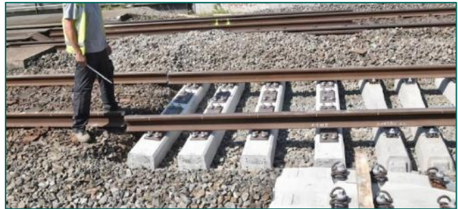
Figuur 19: vervangen bielzen voor betonnen dwarsliggers (Bron: https://www.deorkaan.nl/werk-aan-het-spoor-zaanlijn-zonder-houten-bielzen ).
