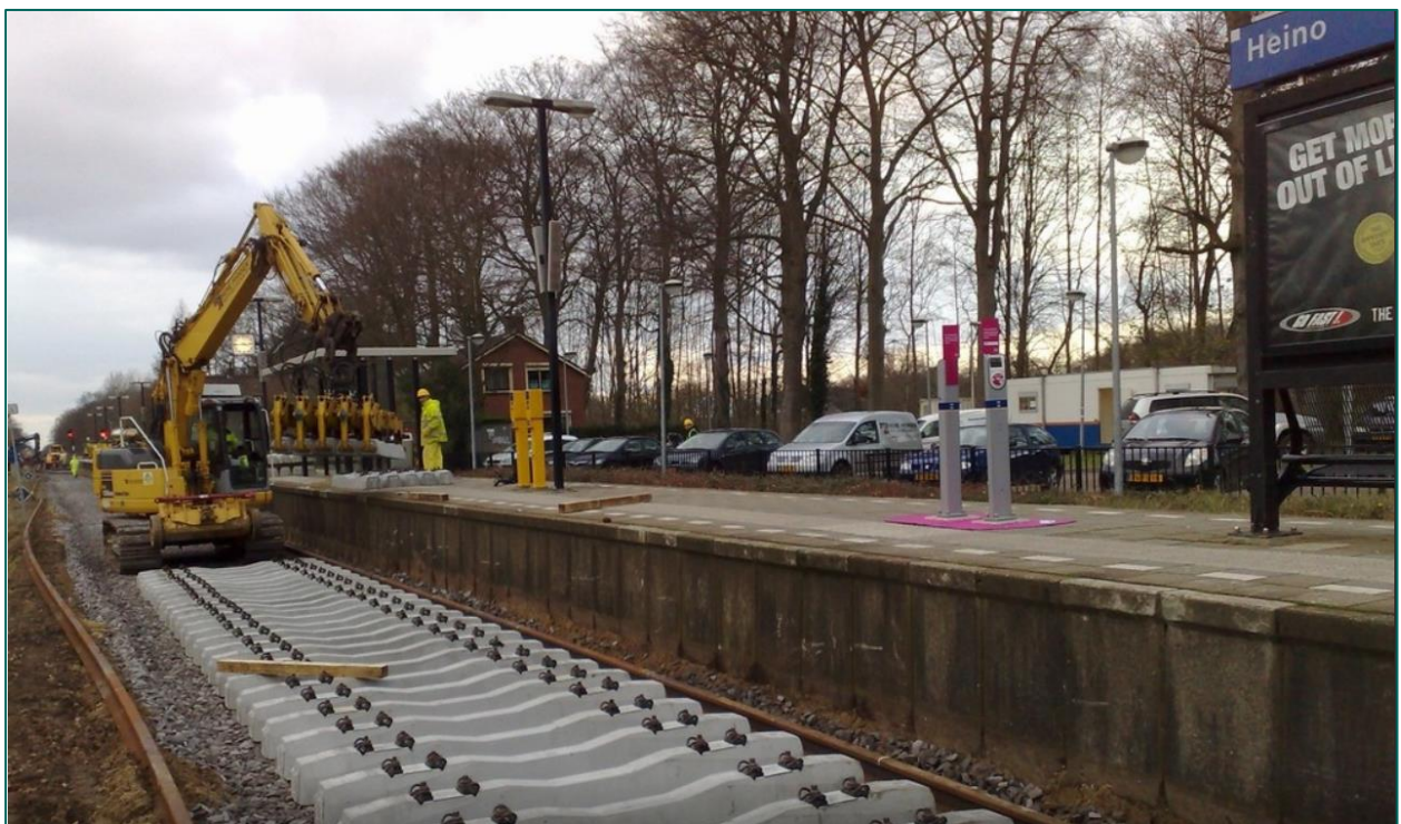
Figuur 22: Spoorbouw ter hoogte van station Heino (Bron: De Stentor april 2017).
