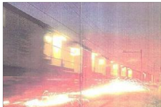
Figuur 2: Het bijlijpen van spoorstaven
