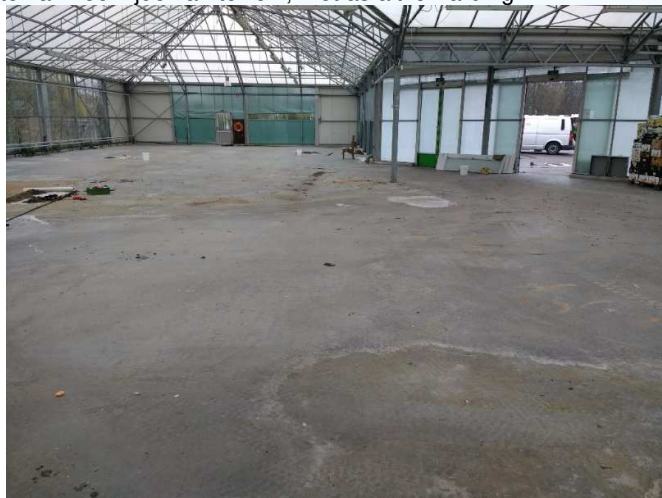
Overzichtsfoto van kassencomplex
