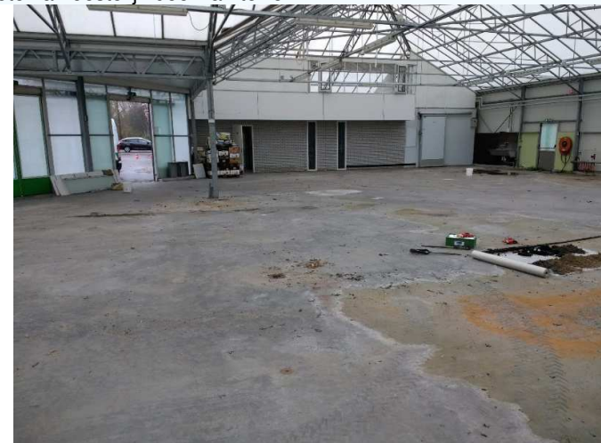
Overzichtsfoto van kassencomplex
