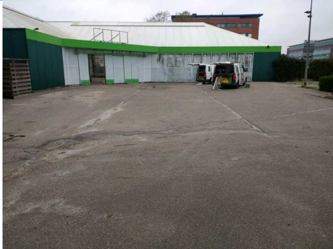
Overzichtsfoto van voorzijde van terrein, met asfaltverharding
