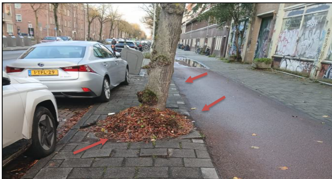
Foto 10: impressie van wortelopdruk bij boom 3 aangegeven met rode pijlen.
