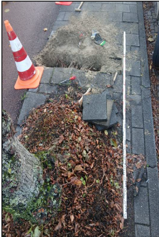
Foto 5: Impressie van proefsleuf A bij boom 3.
