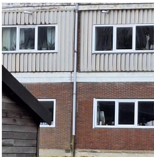
D. kieren in metselwerk en slechte staat plaatmateriaal achterzijde (noordkant)
