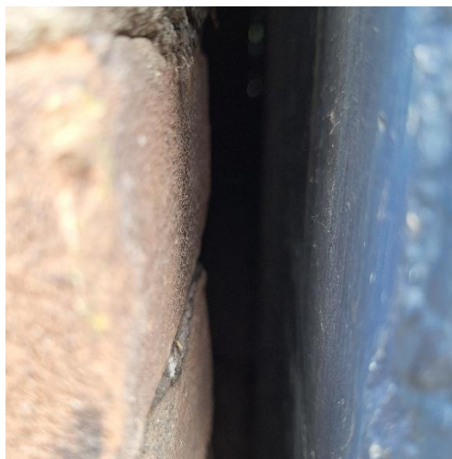
D. kieren in metselwerk en slechte staat plaatmateriaal achterzijde (noordkant)
