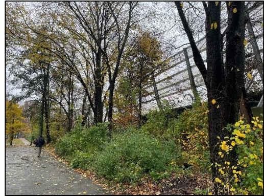
Foto 4. Talud aan de Sinjeur Semeynsstraat
