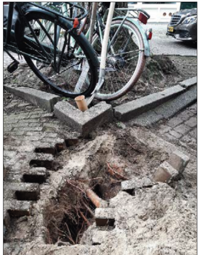
Afbeelding 4 en 5: Beworteling van de iep voor de Daniël Stalpertstraat 85. De dikste wortel is 30 cm dik en ligt 10 cm onder het maaiveld.
