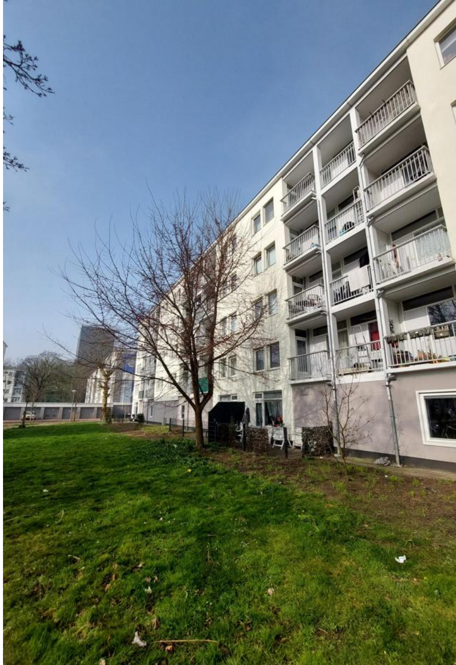
Foto 2. Boom 3108 dicht op de gevel
