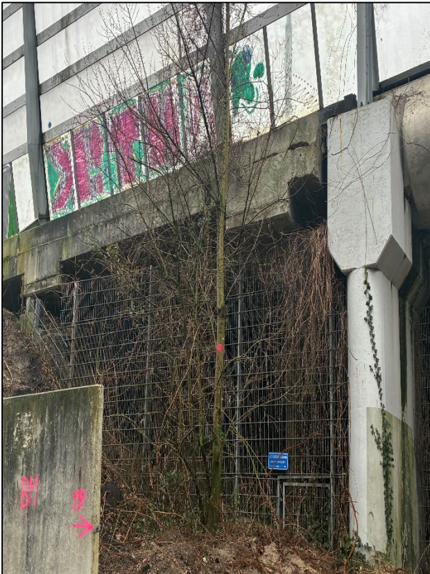
Figuur 12: locatie van boom 14 op geringe afstand van de snelweg.
