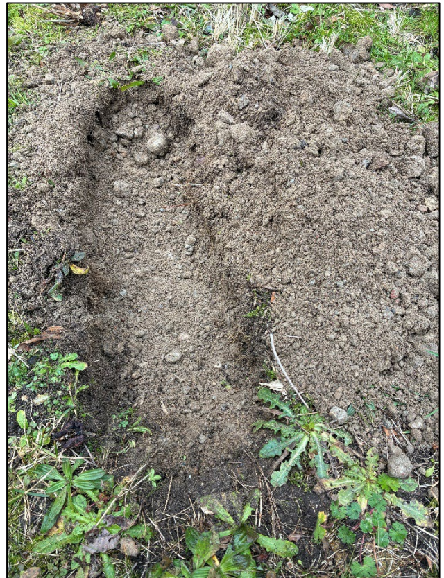
Figuur 15: Overzicht van de gegraven proefsleuf aan de zuidzijde van boom 15 op twee meter afstand van de boom. Harde toplaag bestaat uit gebroken puin.
