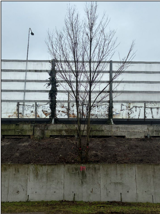
Boom 13 groeit tegen de betonnen keermuur.
