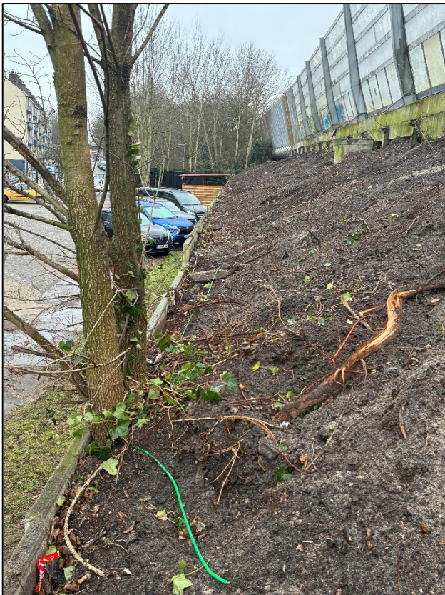
Figuur 12: Zicht op boom 13 met zichtbaar de beschadigde stabiliteit wortel (Ø 5 cm).
