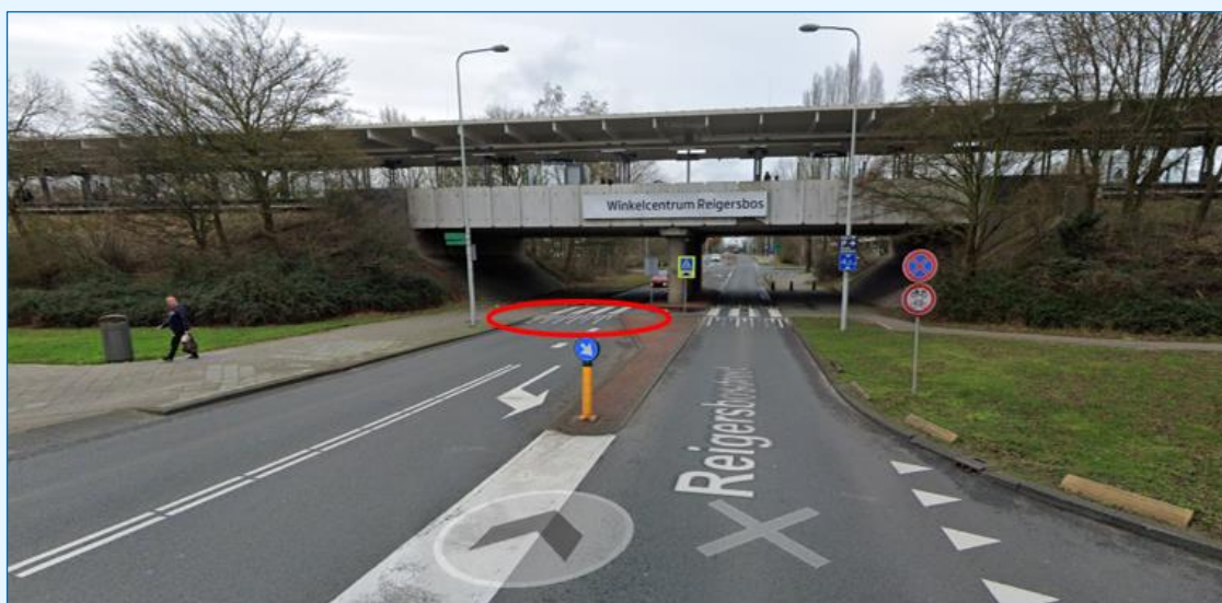
figuur 3: Reigersbosdreef met verkeersdrempel (zebrapad) voor metroviaduct
