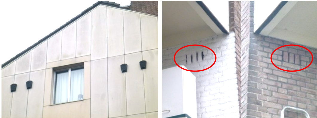
Vleermuiskasten aan de kopgevels van het meest zuidelijke gebouw (links) en open ventilatievoegen bij de balkons (rechts).
