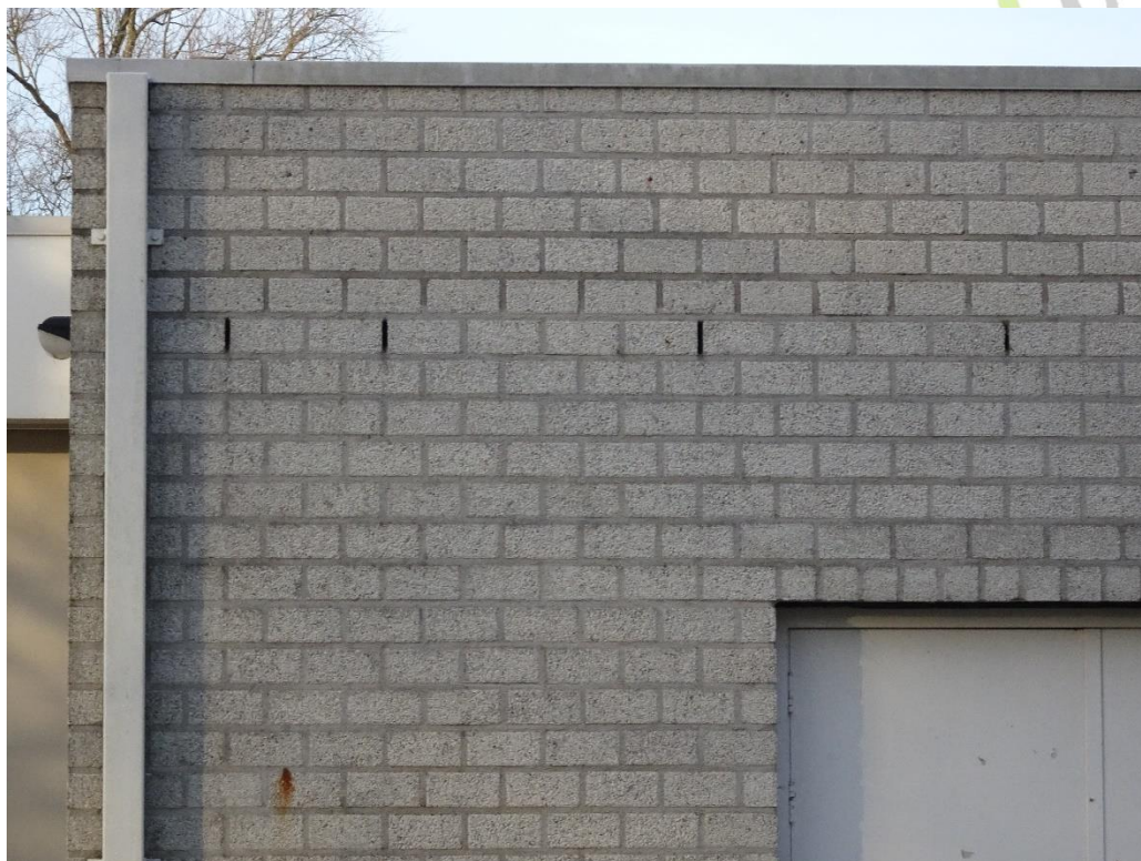
Figuur 13: In het schoolgebouw (Fase 3) bevinden zich openingen: Kieren onder de daktrim en open stootvoegen in de buitenmuren.
