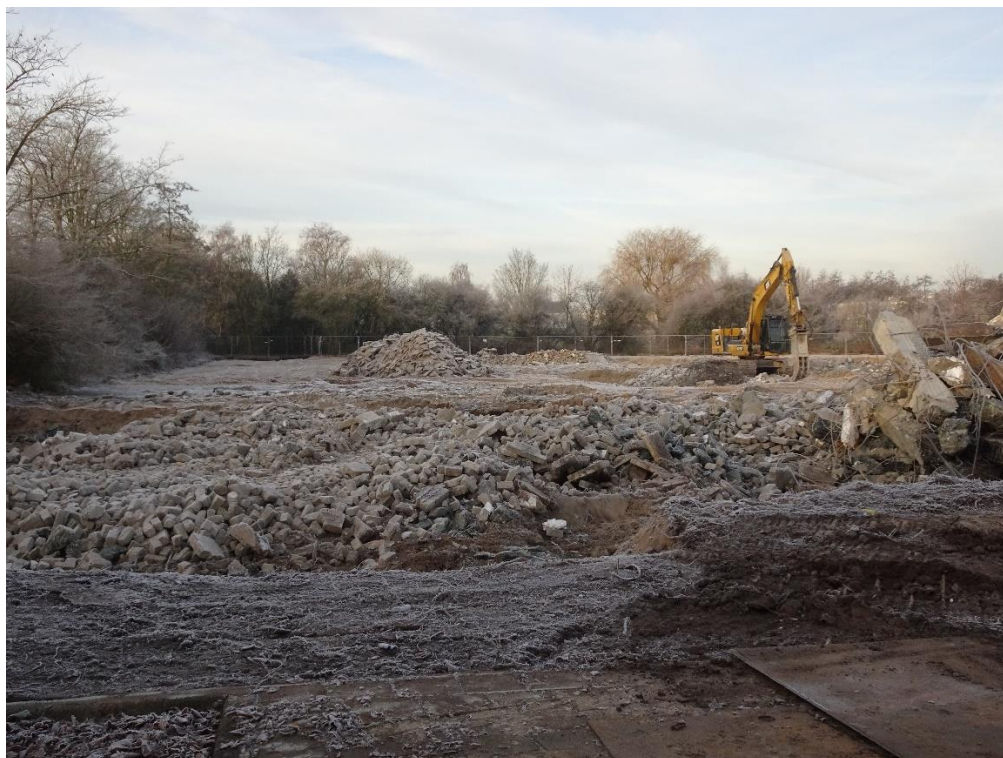
Figuur 10: Een deel van het deel Fase 2, waar alle bebouwing gesloopt is.
