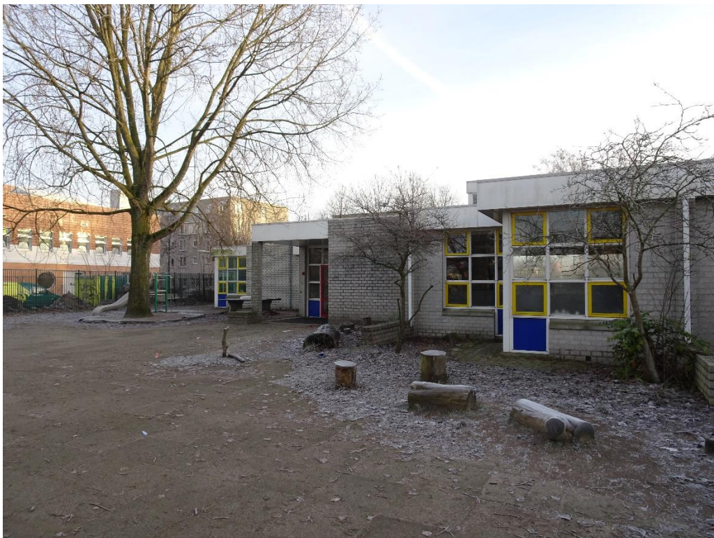
Figuur 12: Het te slopen schoolgebouw binnen deel Fase 3.
