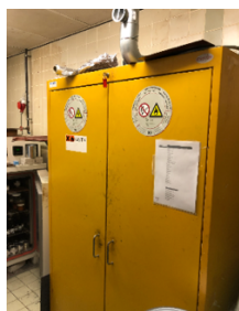
Figuur 5. Laboratorium – opslagkast PGS15, foto's d.d. 05-05-2023.
