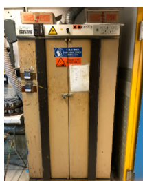
Figuur 4. Laboratorium – opslagkast PGS15, foto's d.d. 05-05-2023.
