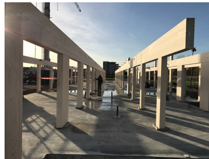
Prefab montagebouw, remonteabel ontworpen
