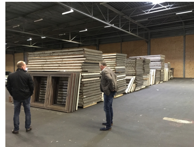
Urban mining; Kozijnen geoogst uit gedemonteerd kantoorpand
