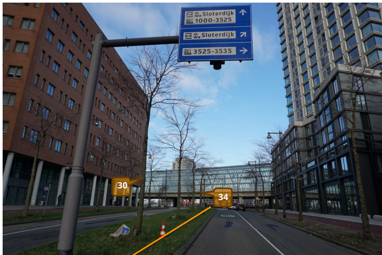
Foto 16: Impressie verhardingslijn toekomstige situatie door aanpassing rijbanen, aangegeven met oranje lijn.
