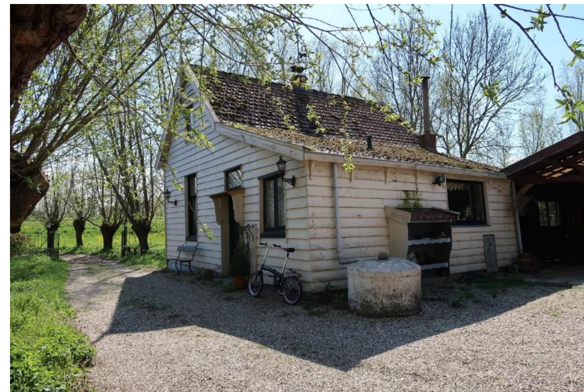
De oostgevel en de lage aanbouw aan de noordzijde. De aanbouw behoort tot de oorspronkelijke opzet van het huis maar is in de late twintigste eeuw geheel opnieuw opgetrokken.
