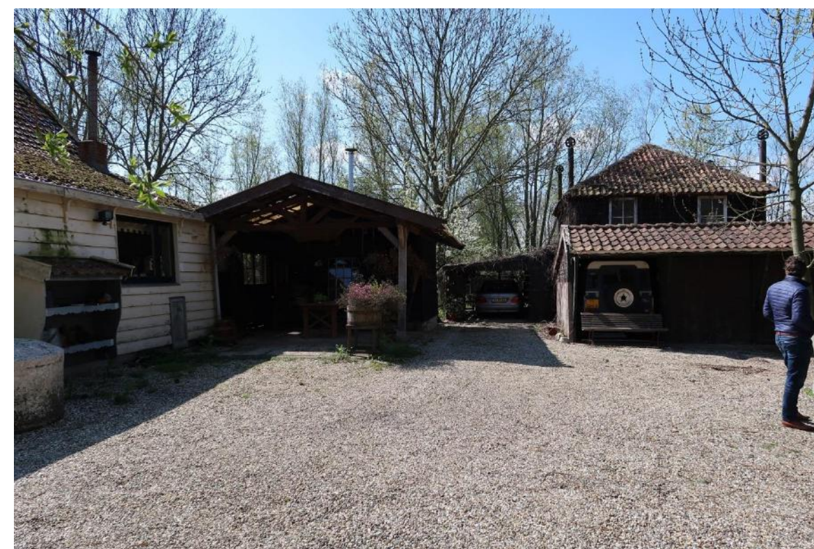
De overige opstallen dateren uit de late twintigste eeuw. Ten noordwesten van het woonhuis staat een tot woonhuis verbouwde hooiberg, die oorspronkelijk van het belendende perceel ten oosten van Hogendijk 7 afkomstig is.
