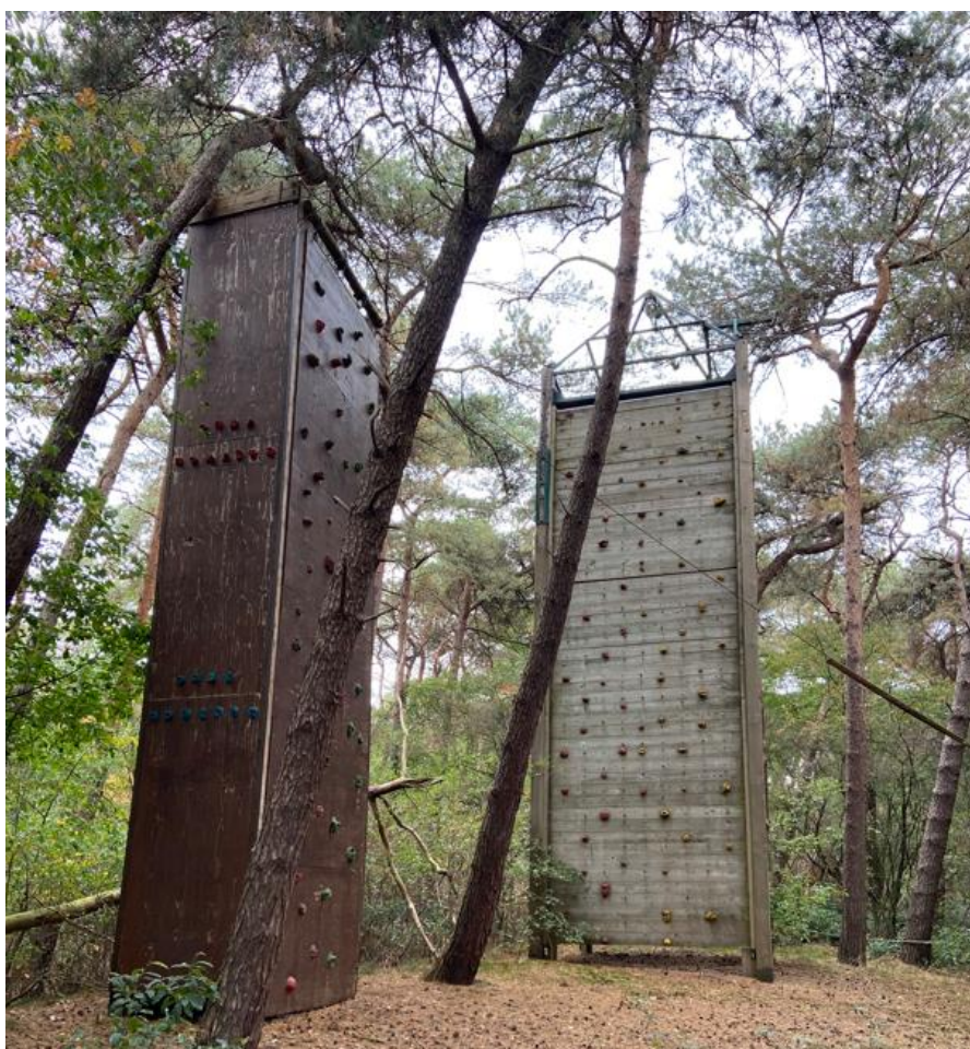
Figuur 8: verwijderde klimtorens (toren 1 (3 x 4m = 12m 2 ) en toren 2 (5 x 5m = 25m 2 ))
