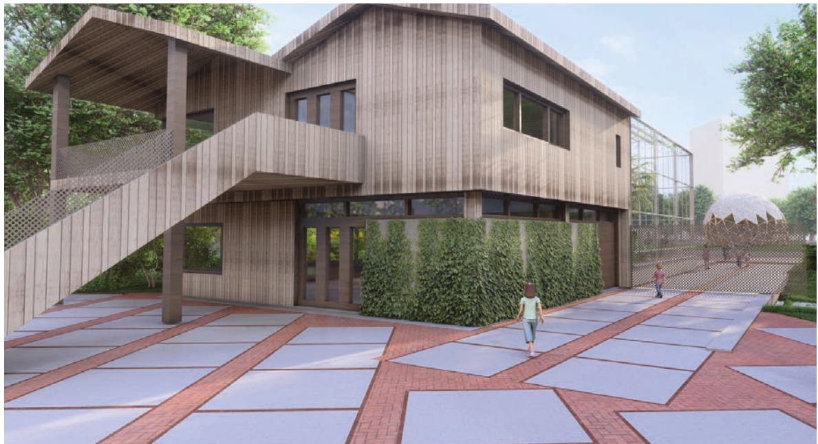
Verharding van herbruikte straatbaksteen en bedrijfsvloerplaten
