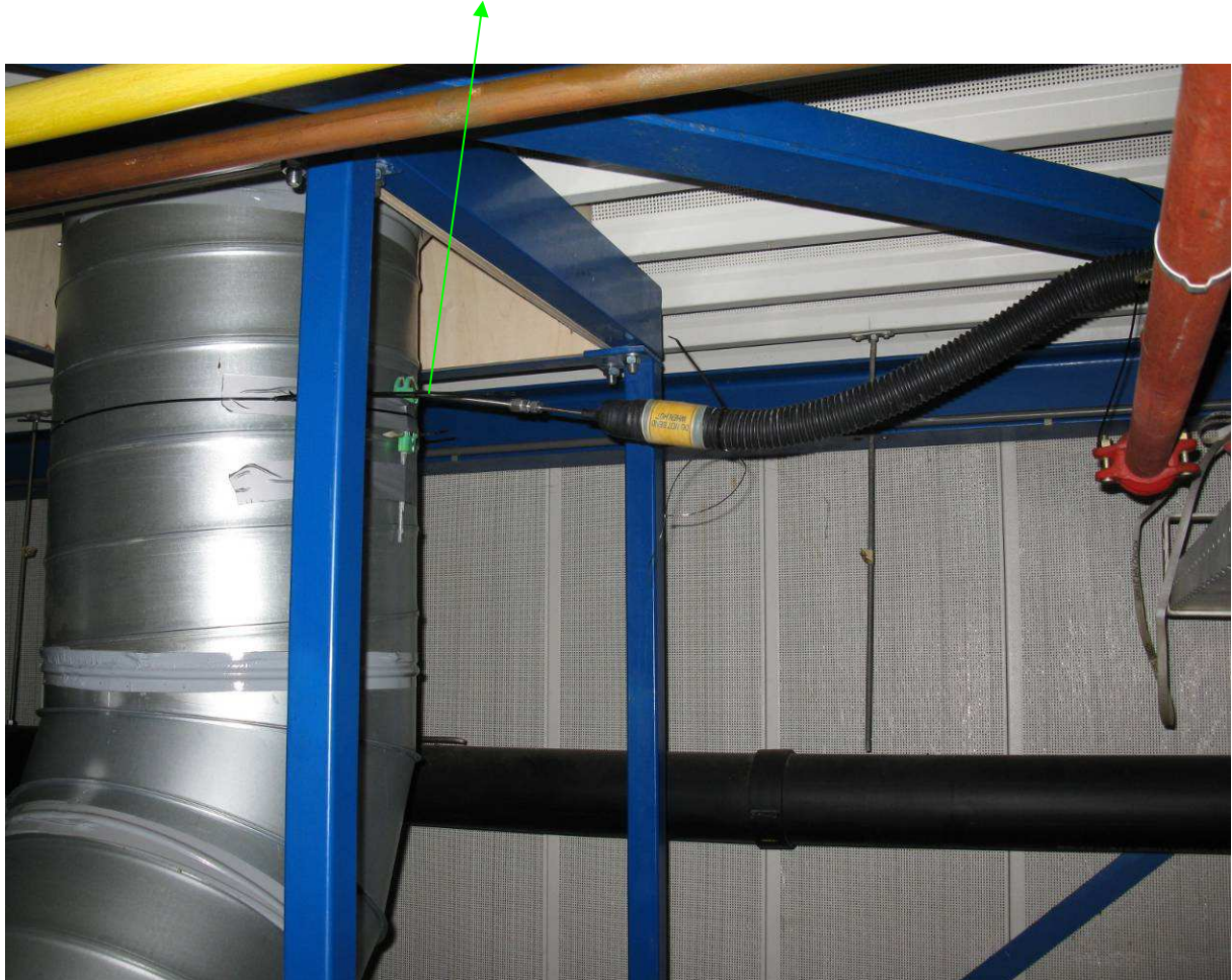
Bijlage 1-2: Foto emissiepunt 2: afzuiging machine PU-6
