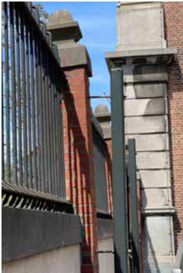
Hulpconstructie: stalen koker 100x100
