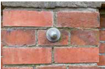
Hulpconstructie: draadeinde met bouten
