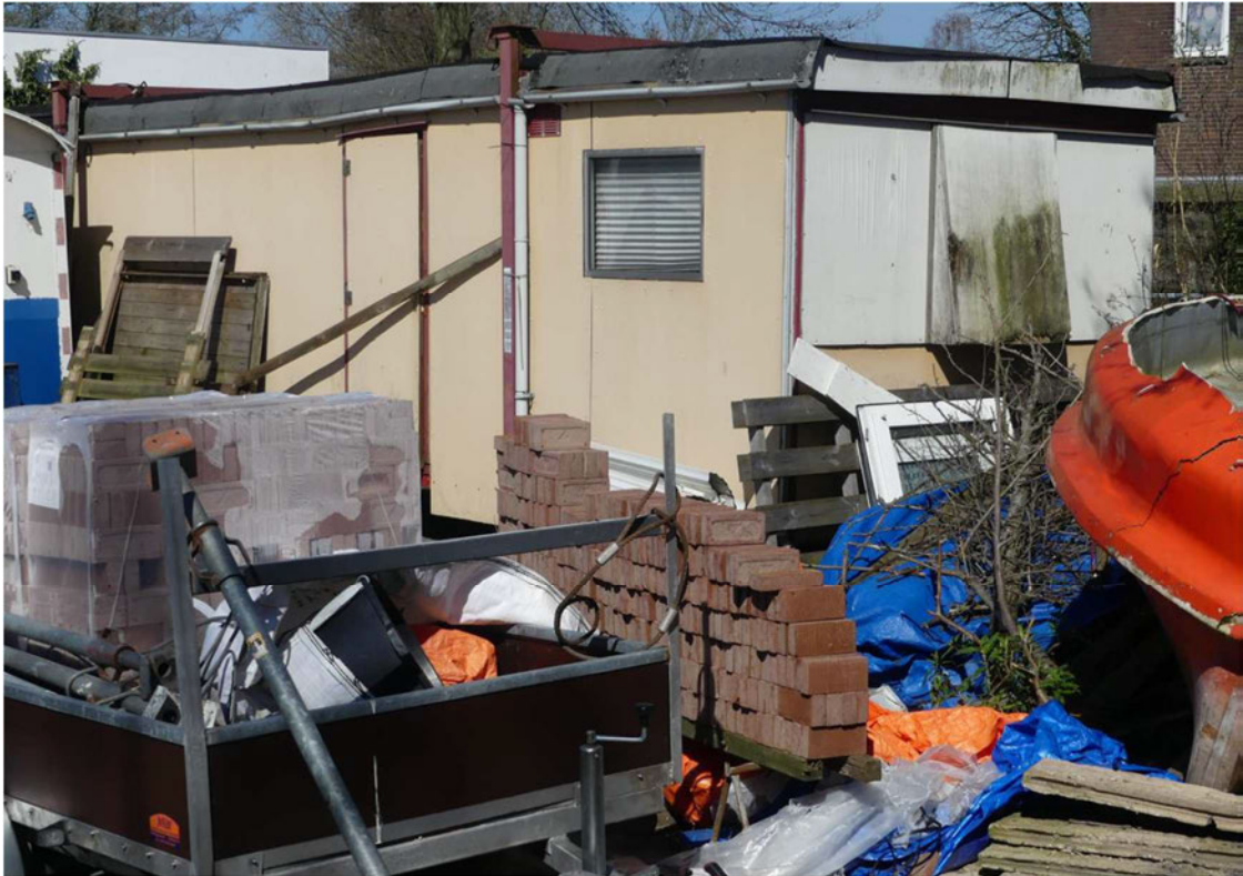
De te verwijderen mobiele unit op het perceel
