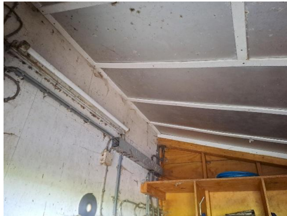
. Afbeelding rechts: Isolatieplaten binnenzijde.
