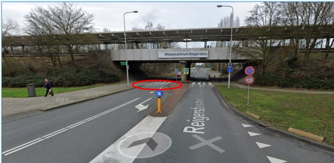
figuur 3: Reigersbosdreef met verkeersdrempel (zebrapad) voor metroviaduct
