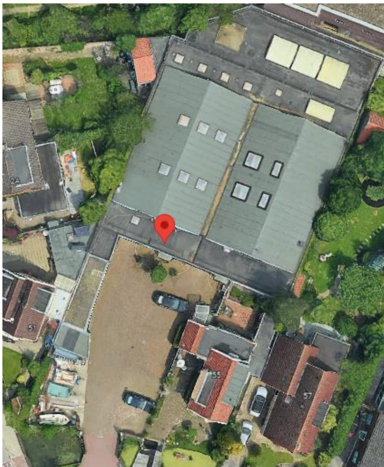
Afbeelding: Luchtfoto bestaande situatie
