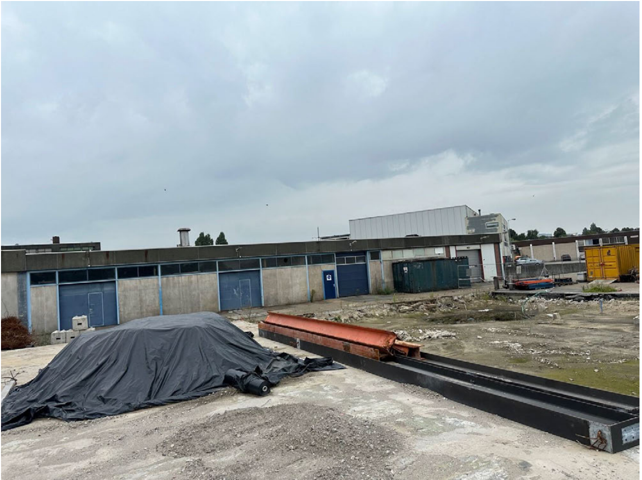
Foto 05: Depot onder folie en liggend op de resterende betonvloer van het vml. bedrijfspand FC-140. Rechts de onderzoekslocatie ter plaatse van de reeds gesloopte betonvloer van het vml. bedrijfspand.
