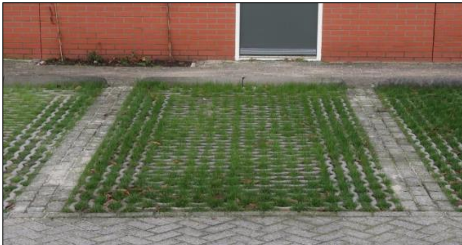
Figuur 9: Halfverharding bij parkeerplaatsen (bron:duurzaamdenhaag.nl).
