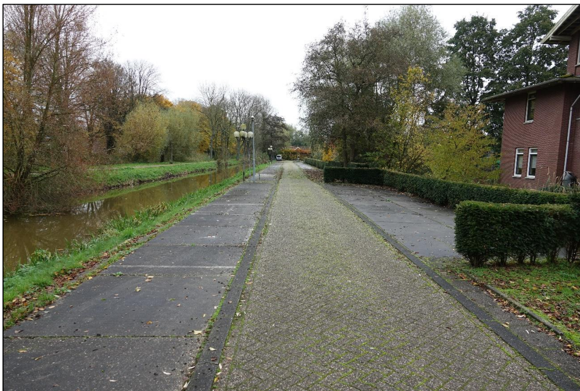
Figuur 2: De oprit richting het plangebied met de sloot erlangs
