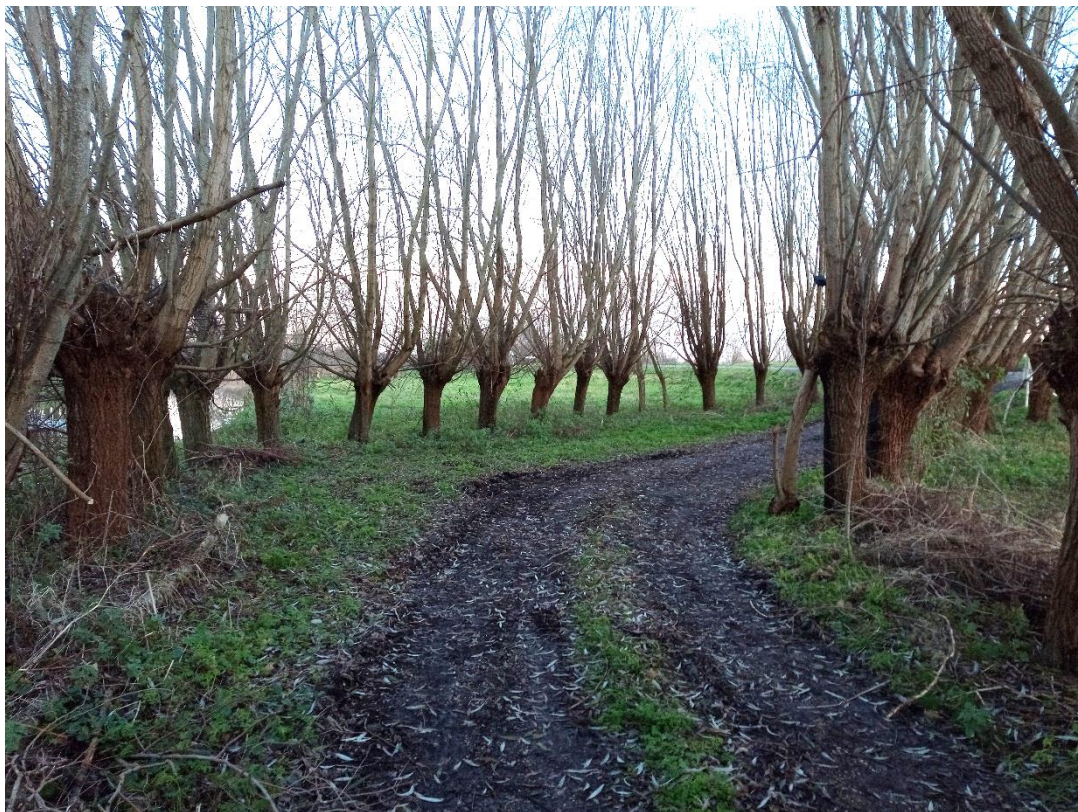
Oprijlaan met twee stroken knotwilgen met een redelijke tot matige conditie. Het zware hout op de knot toont achterstallig beheer.
