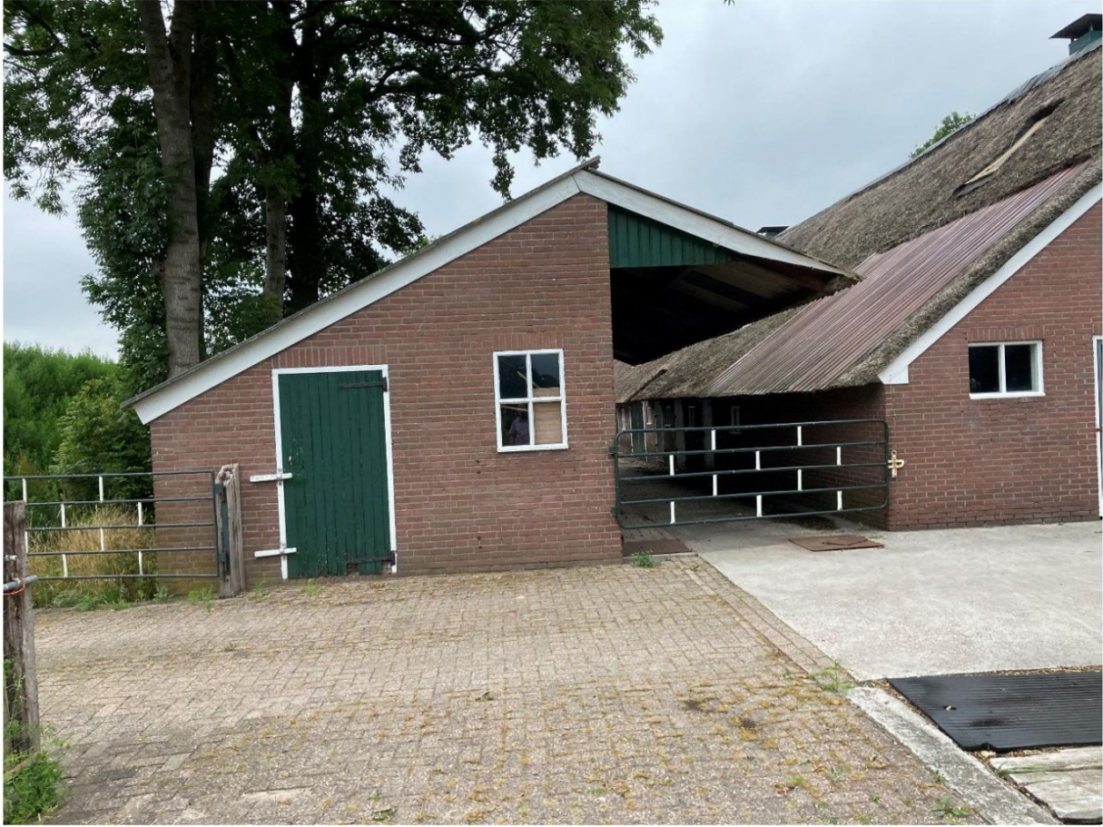
Fig. 7; links te slopen berging; rechts te slopen dakplaat (staal)
