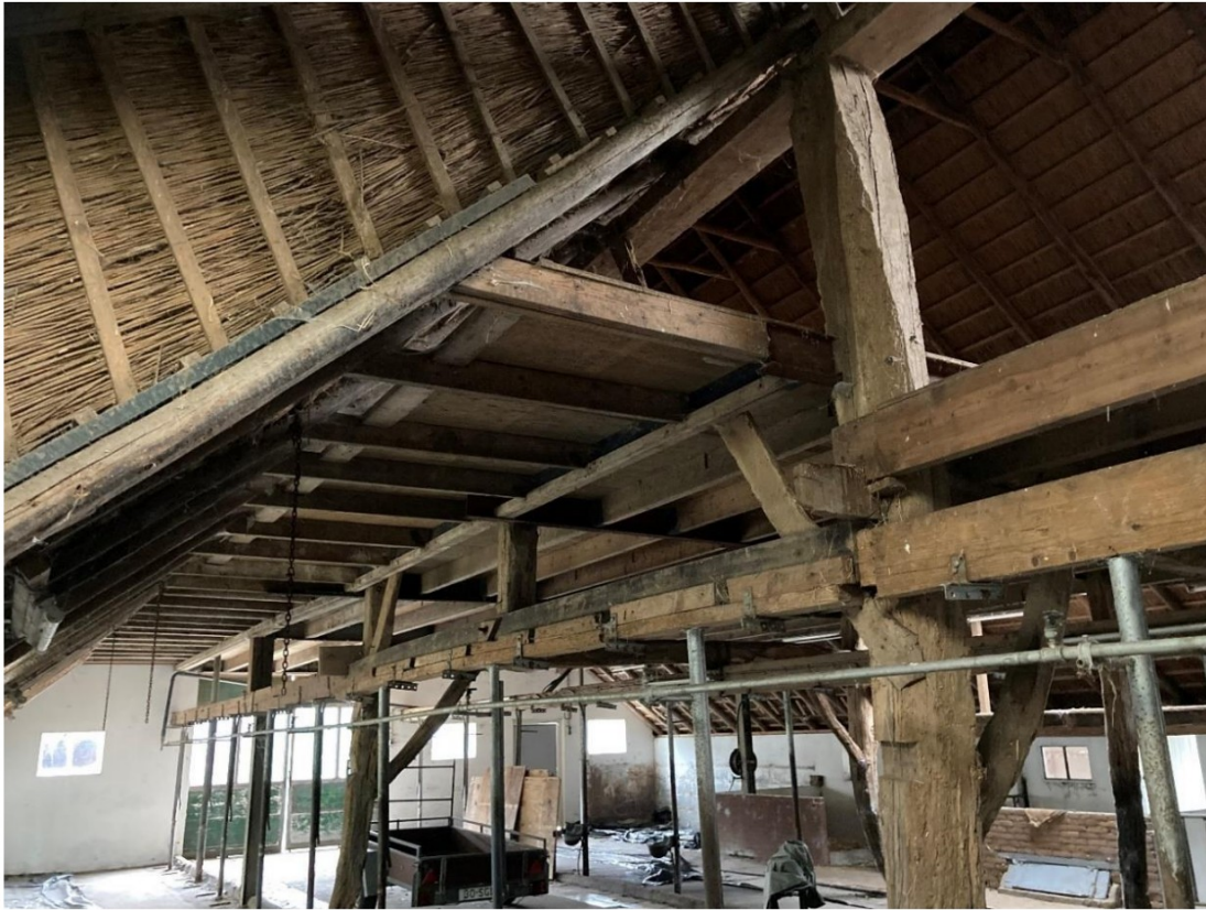
Fig. 1: Afgezaagde gebintpoot herstellen; staalconstructies en extra (later aangebrachte) randbalken verwijderen.
