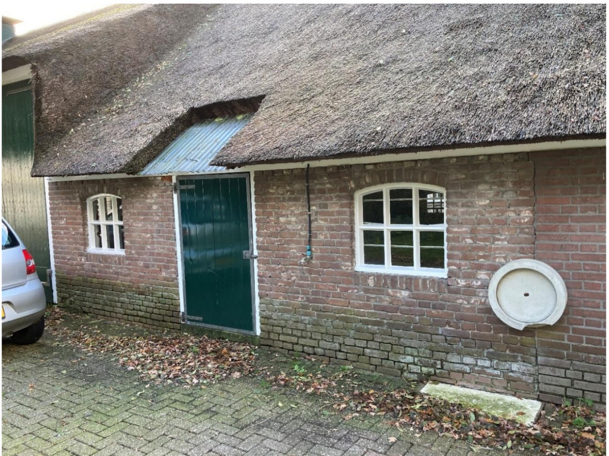
Fig. 4; stalen deurvullingen verwijderen.
