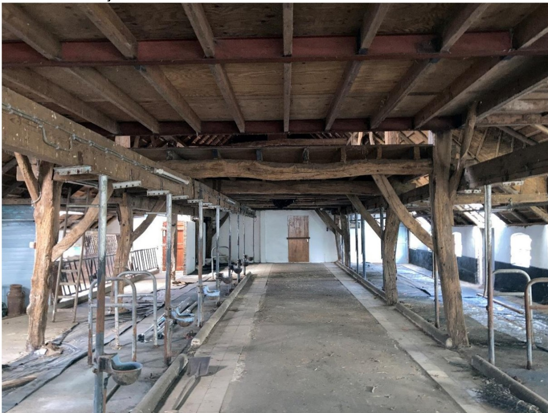
Fig. 2: Stalpoten en inrichting, stalvloer en putten en overbodige houten hulpbalken verwijderen.
