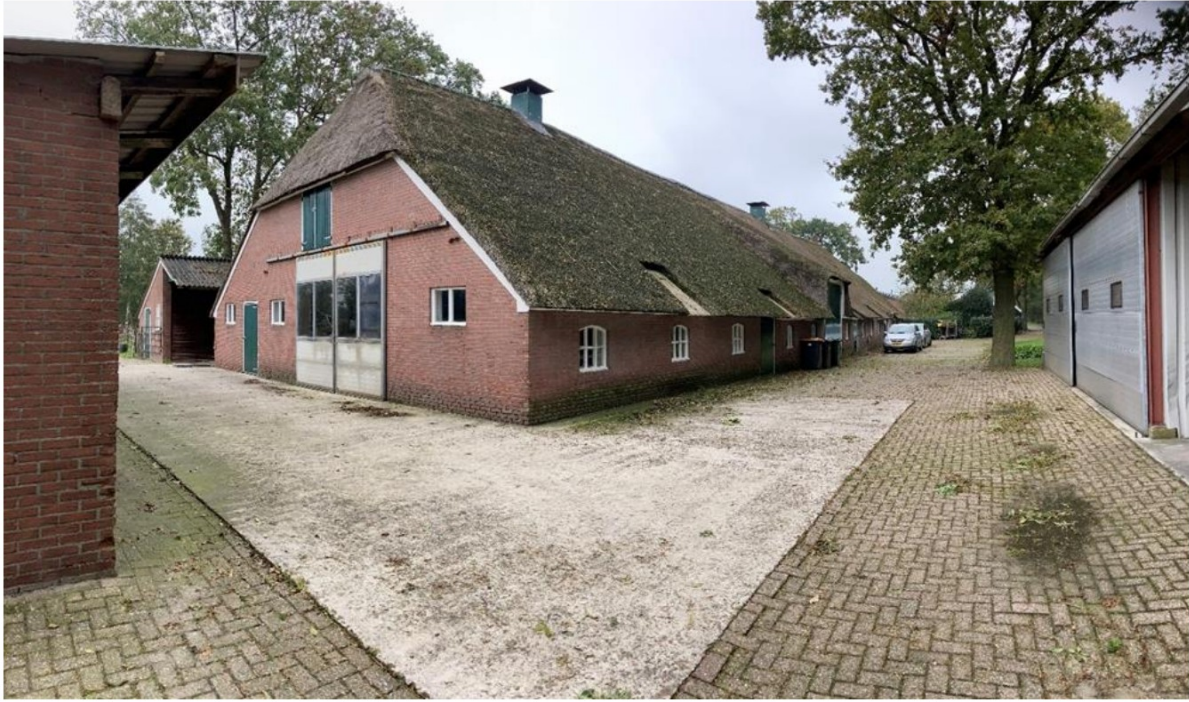
Fig. 3; achtergevel; stalen schuifdeuren worden vervangen door houten puivullingen; put; zie voorgrond gesloopt.
