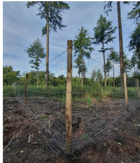
Figuur 6: Ongeschoorde hoekpaal. Snuffeldraad en 2 spandraden. Gaas omgeslagen.
