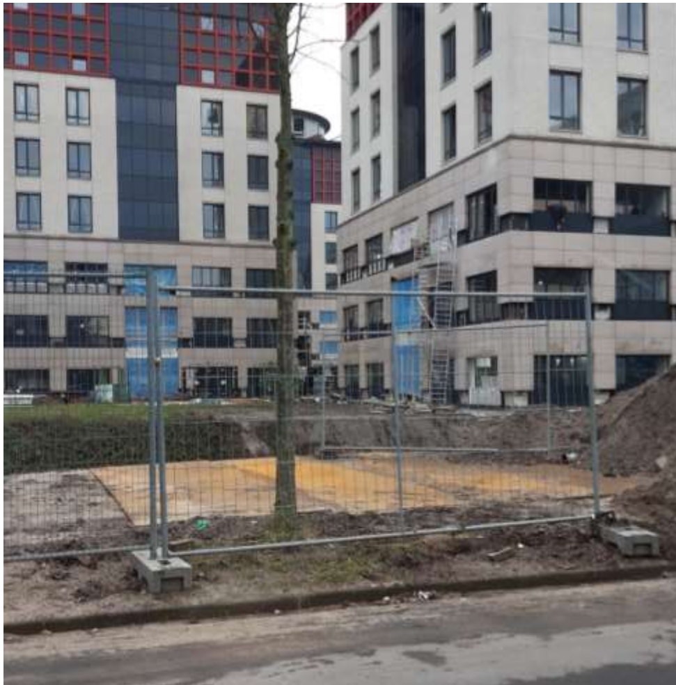
Foto 5 aanwijzingen van uitgevoerde graafwerkzaamheden rond de boom
