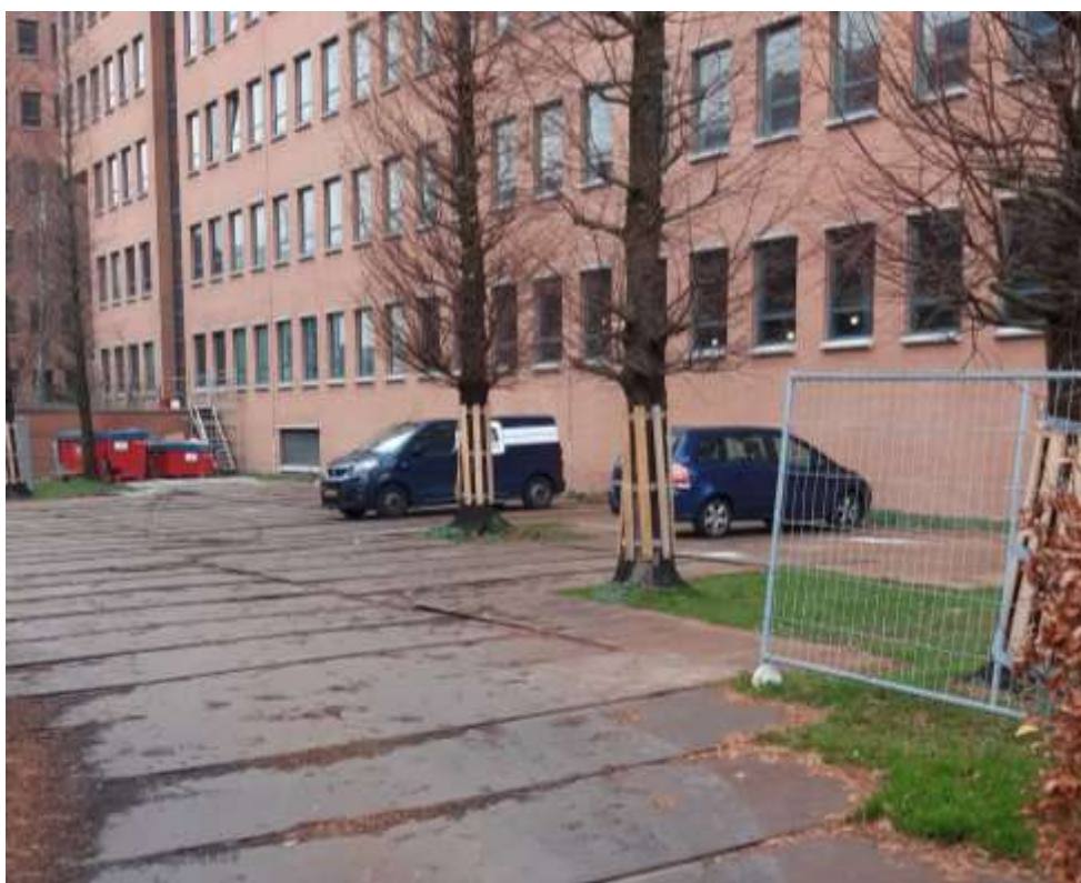
Foto 8 Boombescherming ontbreekt, enkel stambescherming aangebracht
