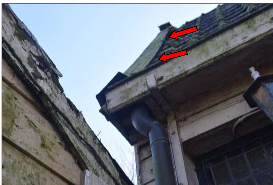
De openingen onder de houten daklijsten (rode pijlen) van de bebouwing geven mogelijk toegang tot voor Huismus en Gierzwaluw geschikte ruimtes.
