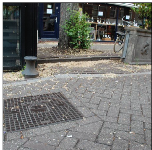
Foto 5: Eerste Van der Helststraat, monumentaaliep 529129, opdruk door boomwortels in rijbaan
