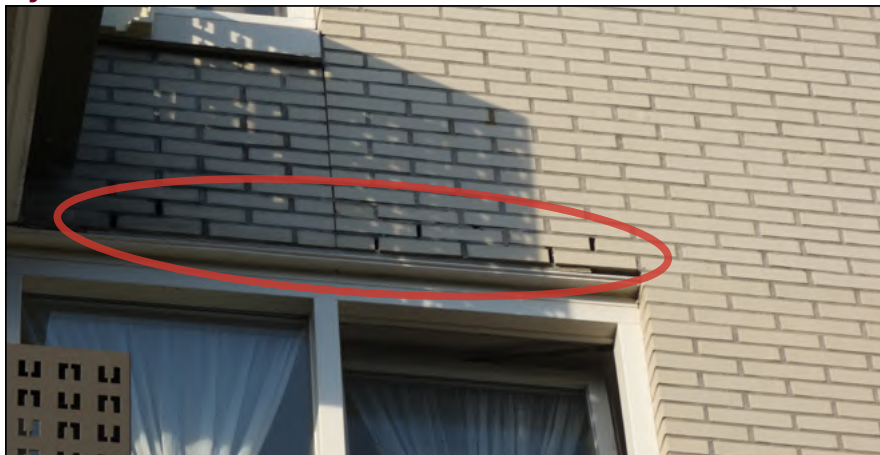
Figuur: Open stootvoegen in het plangebied, hierdoor kunnen (gebouwbewonende) vleermuissoorten de spouwmuur van de bebouwing betreden en benutten als verblijfslocatie.
