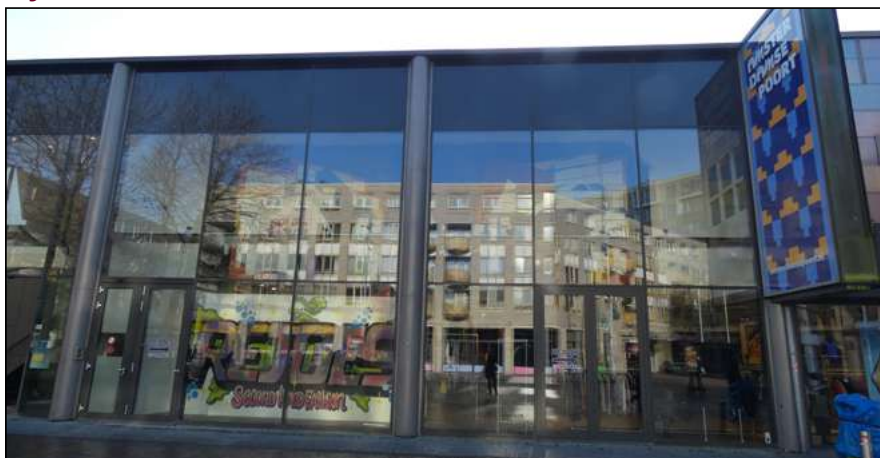
Figuur: Glazen gevel van de bebouwing in het plangebied. Vleermuizen hebben een ruw oppervlak nodig (steen, hout, o.i.d.) om zich aan vast te kunnen houden. Glas heeft dit eigenschap niet en is daarom niet geschikt als onderdeel van een verblijfplaats.
